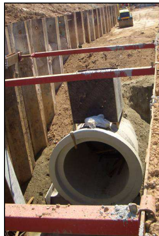
Tuberías para desagüe de mar en la ampliación de la planta de Enagás en el puerto de Barcelona.
